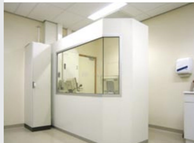
△ Vlietland Ziekenhuis - Schiedam - modulaair wandsysteem
