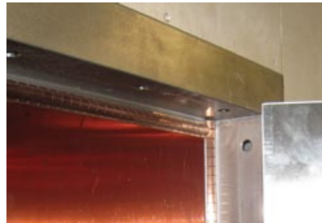
△ RF afscherming - detail
